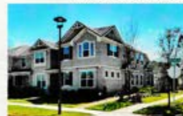
Extérieur maison de ville
